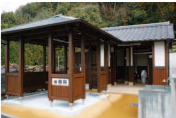
休憩所及び公衆便所整備事業(上大道地区)
