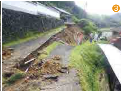
①満倉地区では赤木川が氾濫して道路が陥没、車も押し流されました②小山川では堤防の一部が決壊し、畑が流されました③東小山川地区では、大雨で住宅に続く道が崩落し、通行できなくなりました
