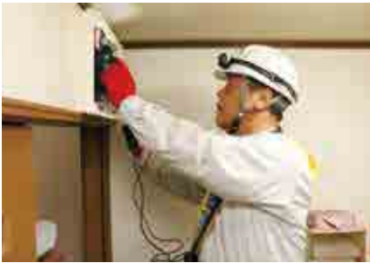
独居高齢者宅で漏電調査を行う南宇和電気工事組合の会員
