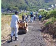
未舗装農道の舗装
