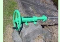
ゲート、バルブの更新
