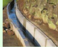
コンクリート水路の更新
