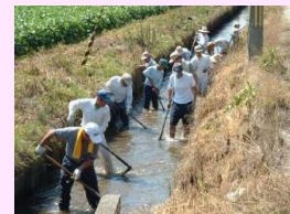
水路の泥上げ
